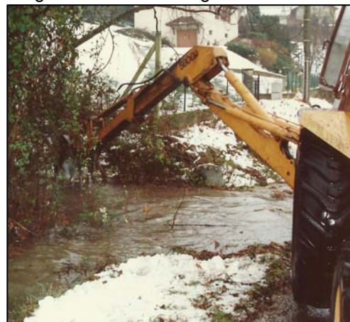
Buse obstruée au niveau de la traversée de la RD. décembre 1991
