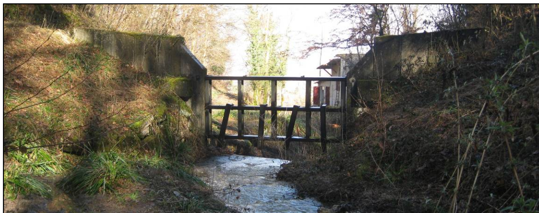
Bassin de piégeage des matériaux du torrent du Rechouchet
